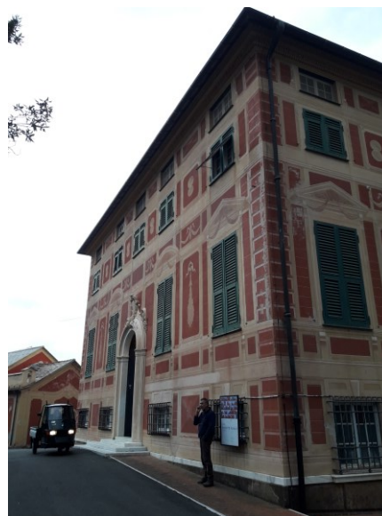
Figura 4.1 - Particolare della muratura che costituisce l'involucro termico opaco
