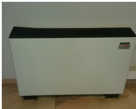
Figura 4.11 - Particolare di un ventilconvettore
