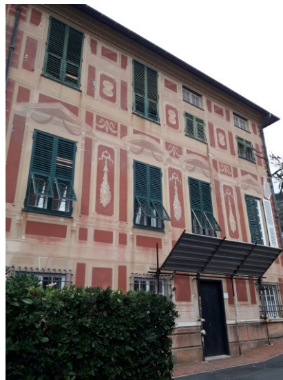
Figura 1.1 - Vista della facciata esposta a sud-est
