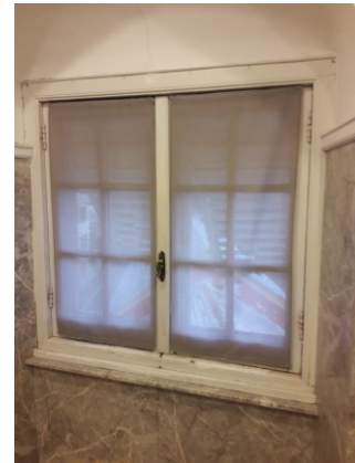
Figura 8.1 - Particolare dei serramenti esistenti
