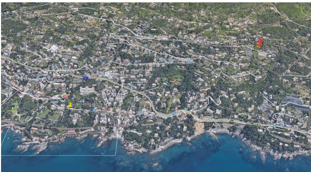
Figura 3.1 – Posizionamento della centralina meteo climatica rispetto all'edificio oggetto di DE
